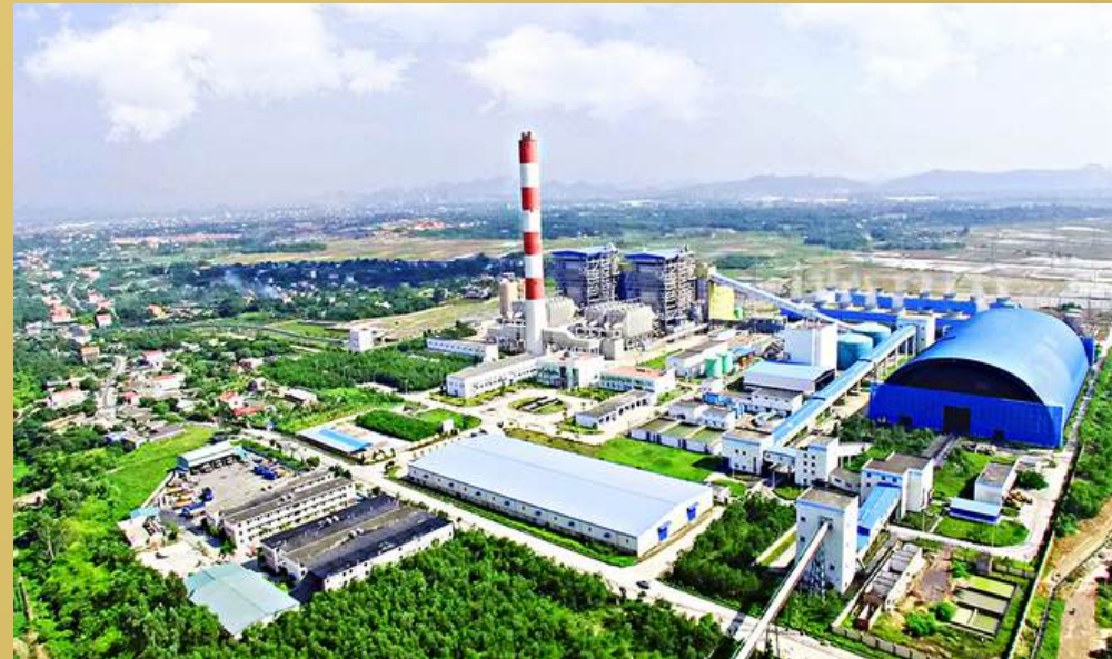
Toàn cảnh nhà máy Nhiệt điện Đông Triều, Quảng Ninh do TKV đầu tư xây dựng
