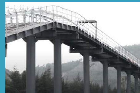
Dự án hệ thống băng tải than từ MBCN mỏ Tràng Bạch đến MB+56 Mạo Khê
